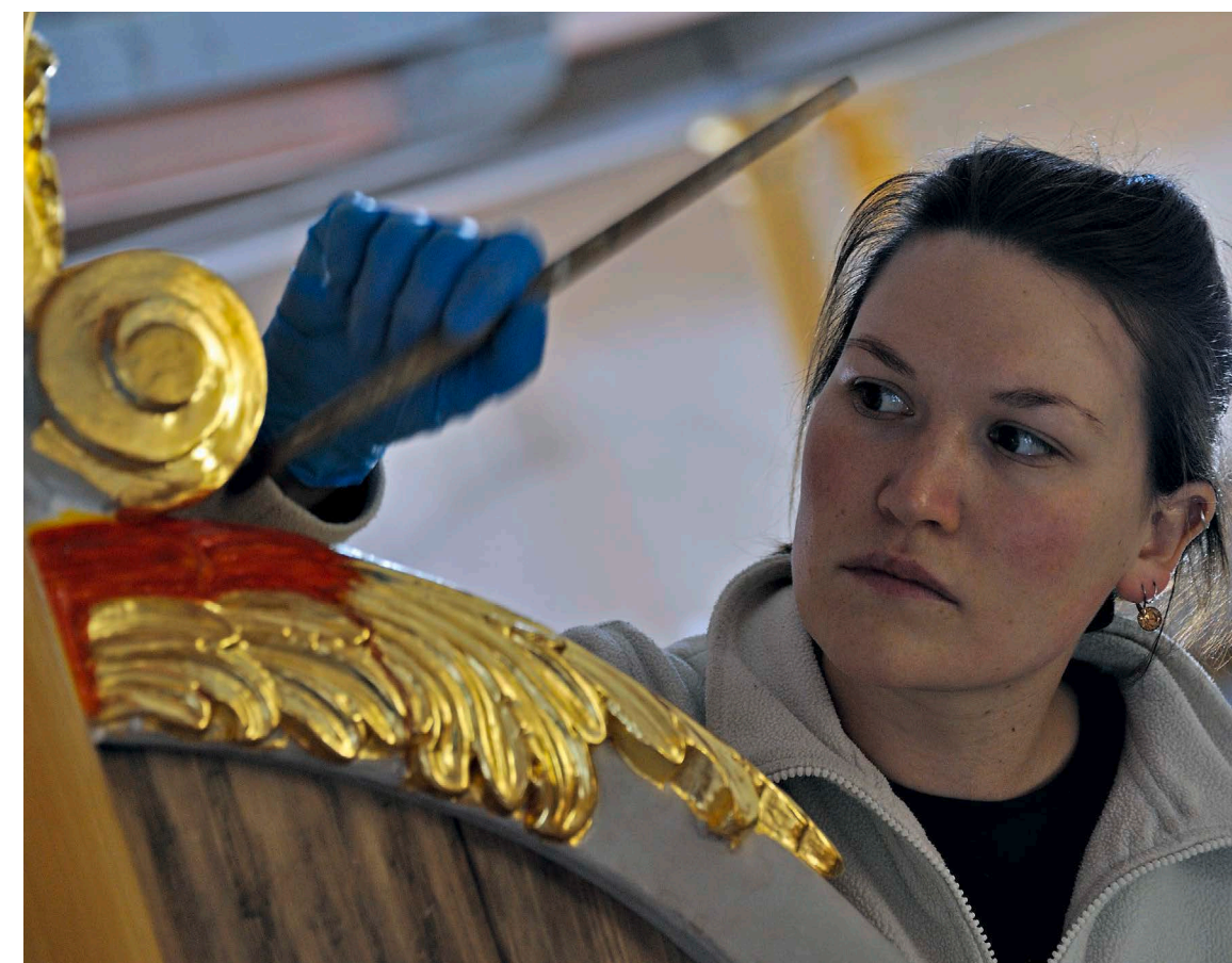
Letzter Feinschliff: Ein Restaurator malt Säulen (l. oben), während Arbeiter die Installation für die Drehbühne voranbringen (r. oben). Blick in den mit Stuck verzierten Raum im Seitenflügel des Schlosses, heute Pausenraum für das Theater (l. unten). Restauratorin Carla Winter lässt ein Ornament erstrahlen (r. unten)
